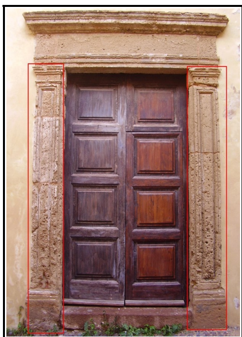
Figura IV : particolare delle lesene del portale
